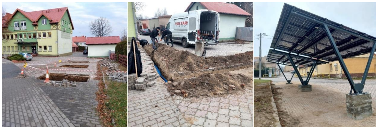
Efekt realizacji inwestycji:
