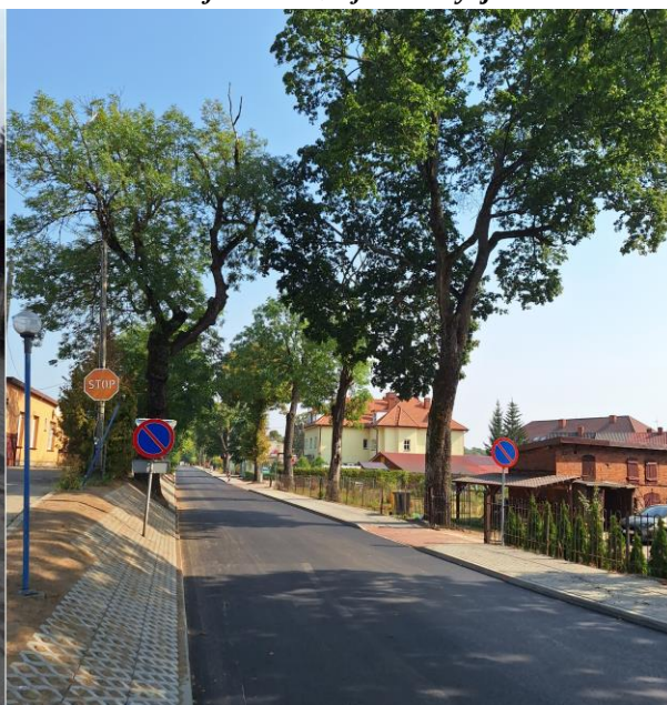
Efekt realizacji inwestycji:
