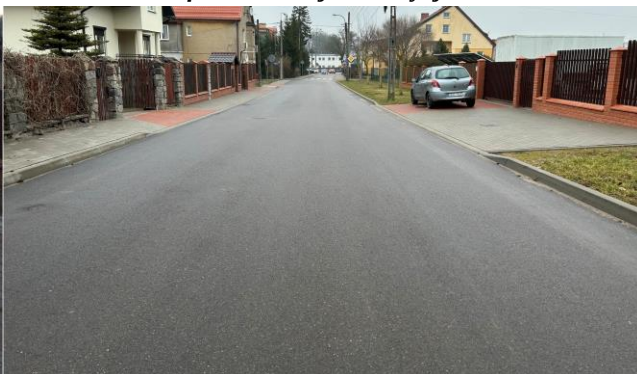
Efekt realizacji inwestycji:
