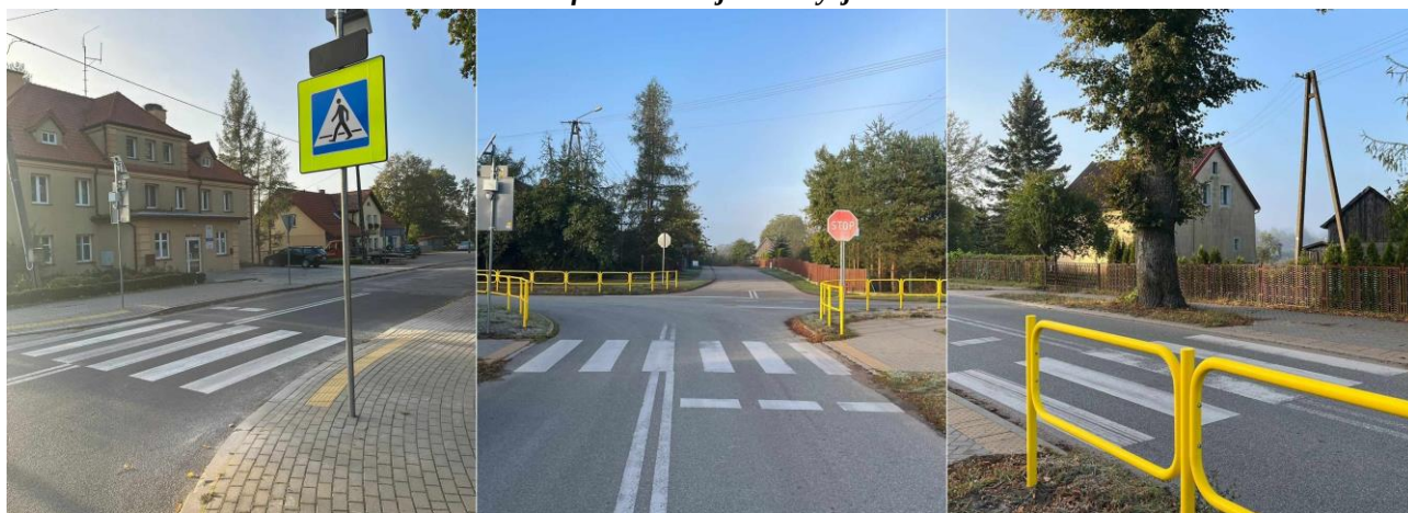
Efekt realizacji inwestycji:
