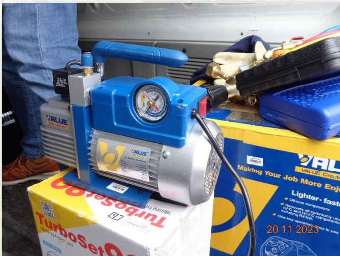
wykonywanie instalacji klimatyzacyjnych
